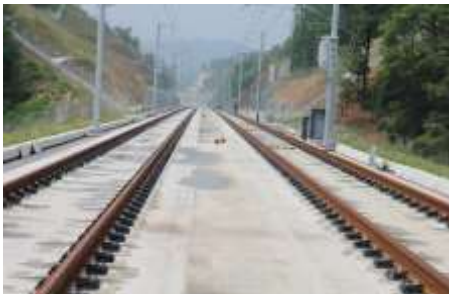
[KR형 레일체결장치 부설전경]
